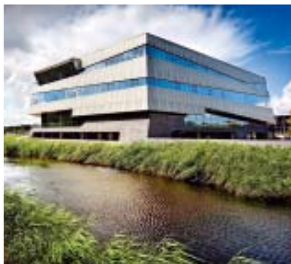
Durch die leichte Neigung gelten die oberen Ebenen nach niederländischer Bauvorschrift als Dach.
