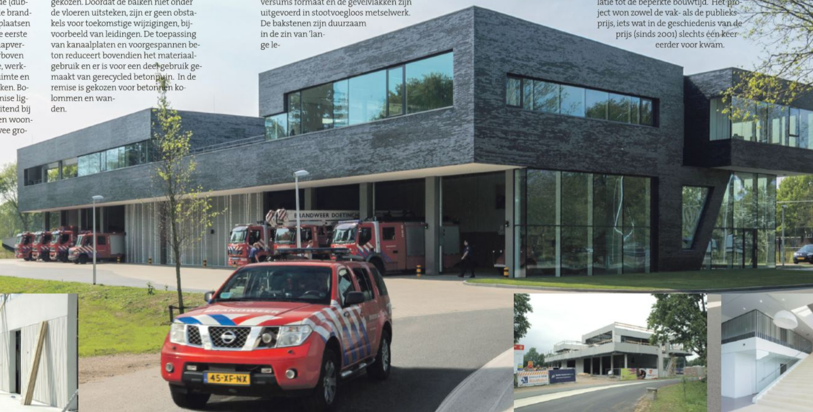
Bij de situering van het complex moest onder meer rekening worden gehouden met een ecologische aanvliegroute voor vleermuizen.
